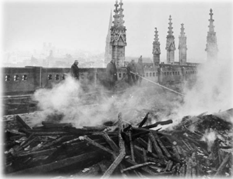
État de la charpente de la cathédrale après l'incendie
